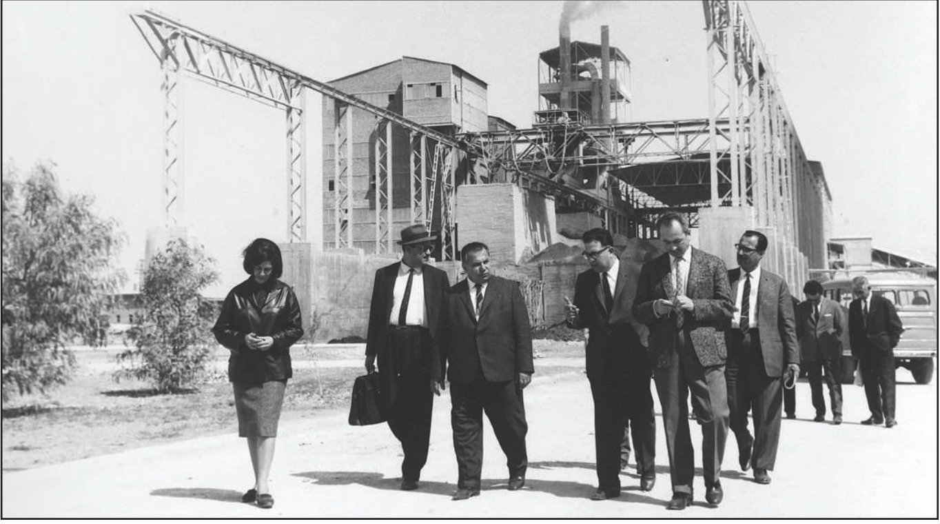
Adana Fabrikası'nın genişletilmesinden sonra yapılan ziyaretten bir görünüş, 1965 (Necati Nemutlu arşivi).
