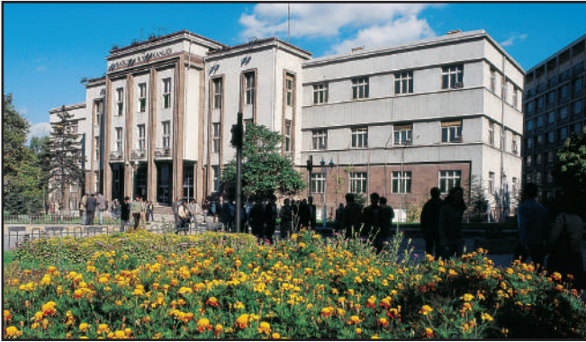
Sağlık Bakanlığı Binası, Ankara (Afife Batur arşivi).
