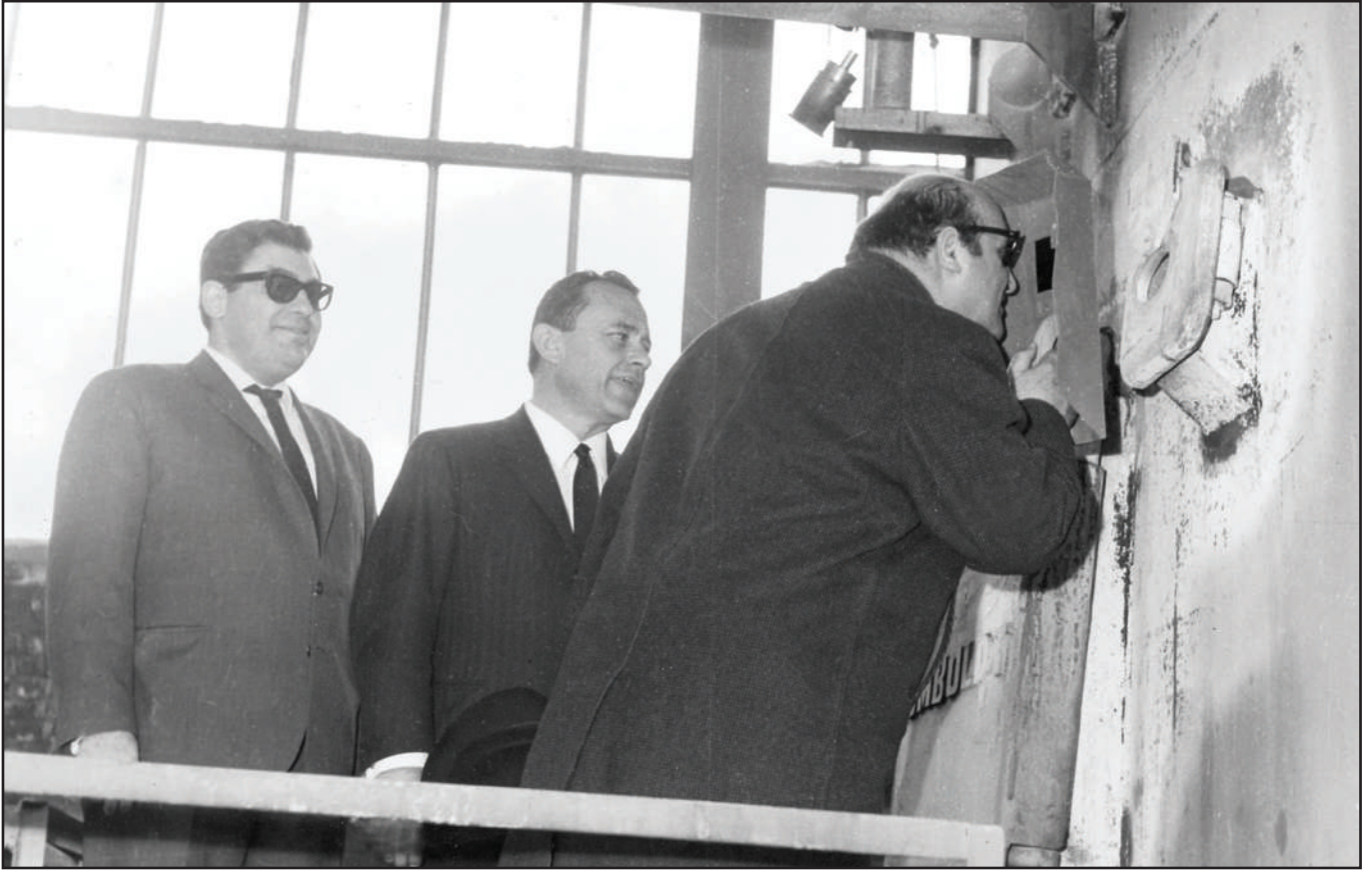
Ankara Çimento Fabrikası'nın 2 nolu döner fırınının işletmeye alınışı: Başbakan Süleyman Demirel firmı izliyor, 1968 (Ankara Çimento Fabrikası arşivi).
