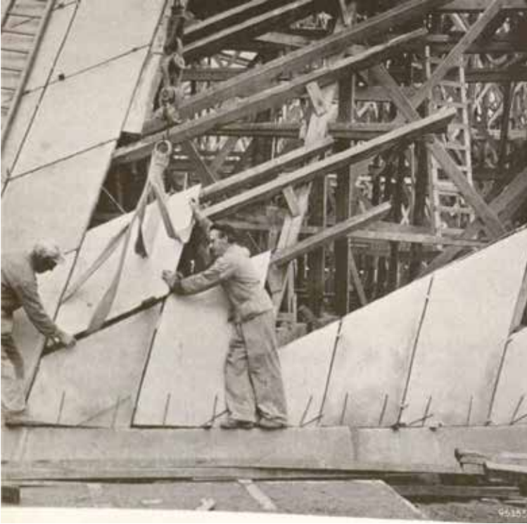
6 5 cm kalınlığındaki beton birimlerin dökümünde kullanılan kum kalıp (Kaynak: Philips Technical Review, 1958/1959).
