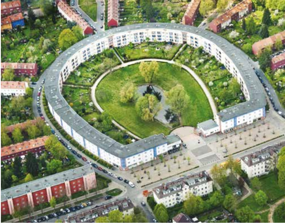
1 Hufeisensiedlung Britz, Berlin, 2014 (Fotoğraf: Ben Buschfeld). 2 Yerleşkede at nalı formunun merkezindeki gölet (Fotoğraf: Ben Buschfeld). 3 İnşası sırasında Hufeisensiedlung (Kaynak: Die Wohnungswirtschaft, 1925).
