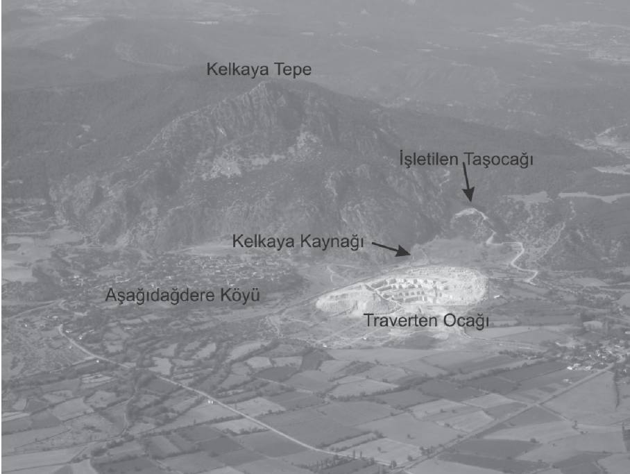
Şekil 2. İnceleme alanının genel görünümü.
