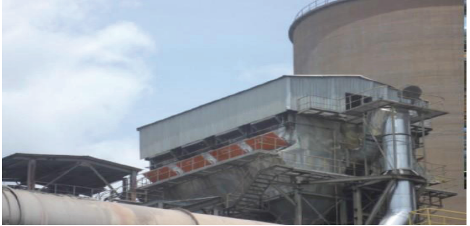
Fotoğraf 9 – Toz Kömür Jet Filtresi ve Giriş Borusunda Diverter Vana
