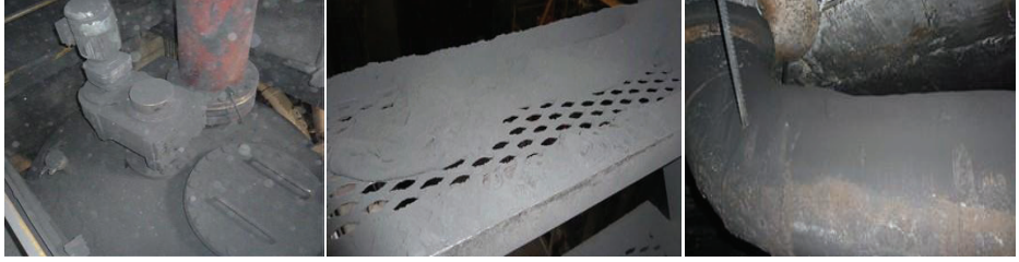
Fotoęraf 5 – Kömür Hazırlık Alanı Bina İçi Yüzeylerde Aşırı Toz Birikimi Örnekleri
