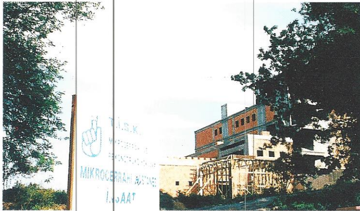
Microcerrahi Hastanesinin inşaatının son durumu
